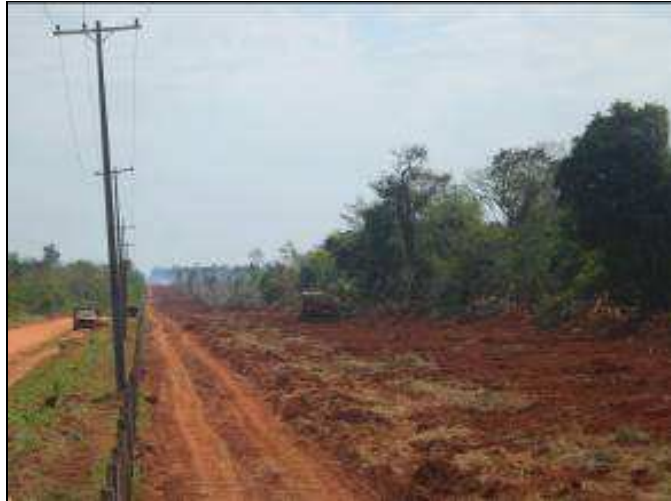
Foto 3. Franja en el lindero sur.
